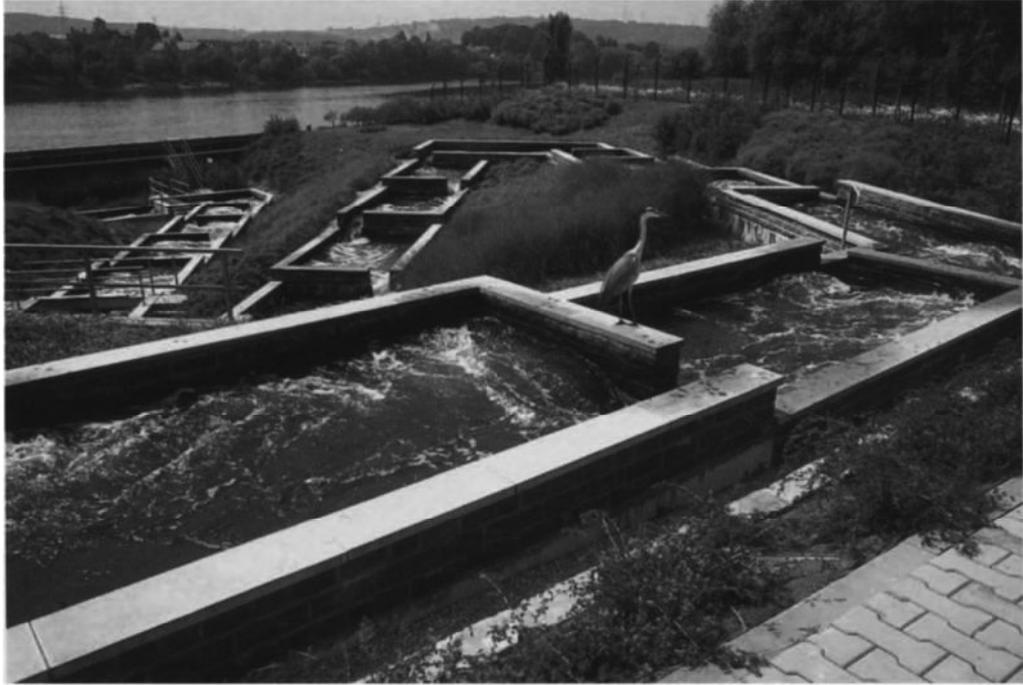
*La nouvelle échelle à poissons de Lixhe, une passe dite «à bassins». La chute du barrage est corrigée par une succession de petites chutes qui, chacune, se déversent dans un bassin (Photo J. Houttekier).*
