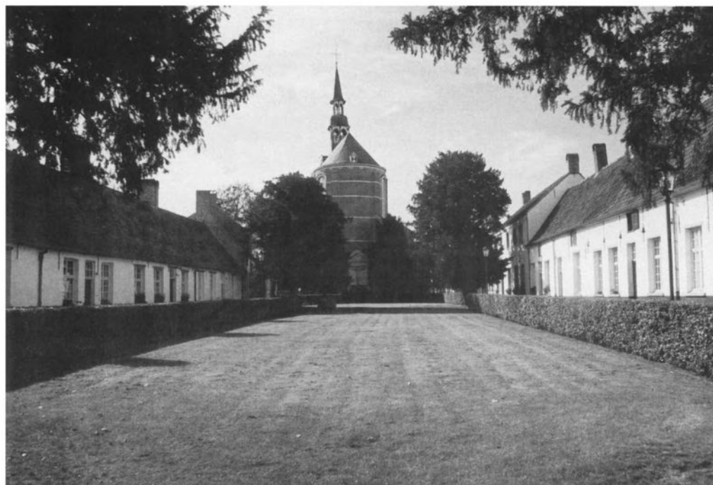
Après la rénovation (Photo P. Zeyen).
