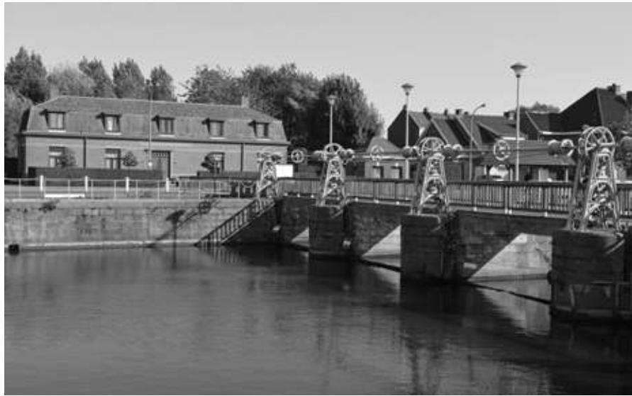
Pour rendre la Lys accessible à des bateaux de plus fort tonnage, il fallait construire une nouvelle écluse en aval en direction de Wervik. Celle-ci date de 1989 et mesure 195 mètres de long pour une largeur de 12,5 mètres.
