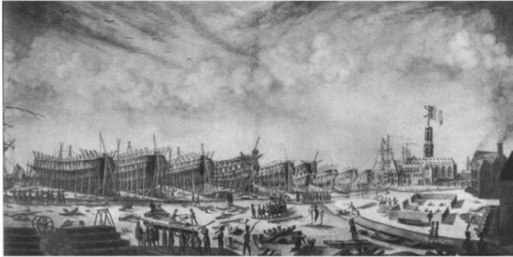
Anonyme, «Vue des chantiers de l'arsenal maritime du port d'Anvers sous le régime français», dessin, Bibliothèque royale, Cabinet des estampes, Bruxelles.
